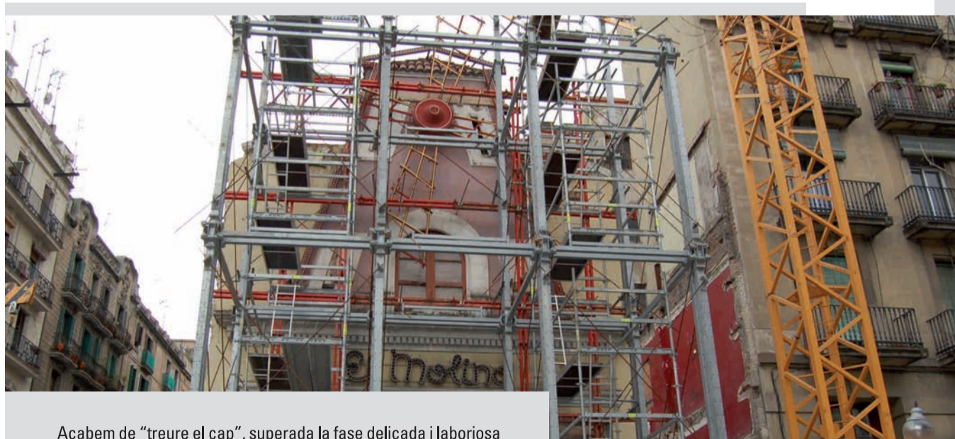
Estat actual de les obres d'El Molino.
